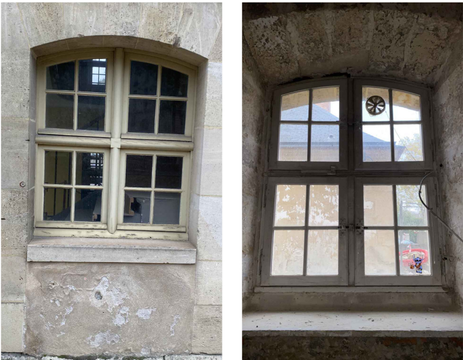
MENUISERIE DE TYPE B : Fenêtres à croisée du RDC (1.30*1.58 m)
