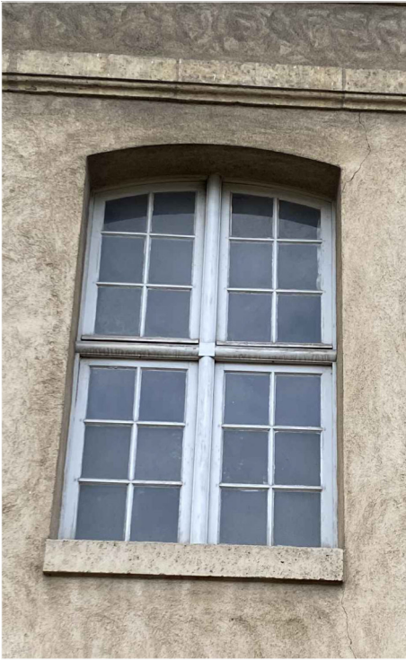
MENUISERIE DE TYPE E : Fenêtres à croisée du R+1 (1.30*2.25 m)
