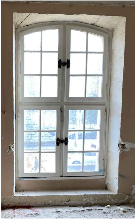
MENUISERIE DE TYPE E : Fenêtres à croisée du R+1 (1.30*2.25 m)
