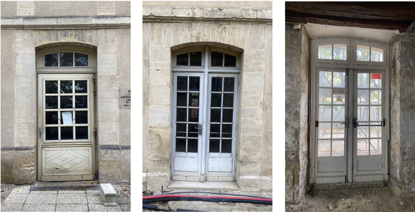
MENUISERIE DE TYPE A : Porte à un ou deux vantaux (1.30*2.5m)
